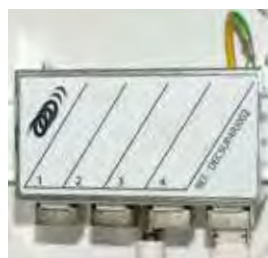
Support d'embases en métal avec Interface réseau TV + Informations en face avant
