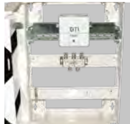
2 Rails DIN pour recevoir DTI et accessoires divers
