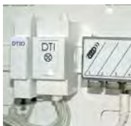
Montage des équipements sur rail DIN
